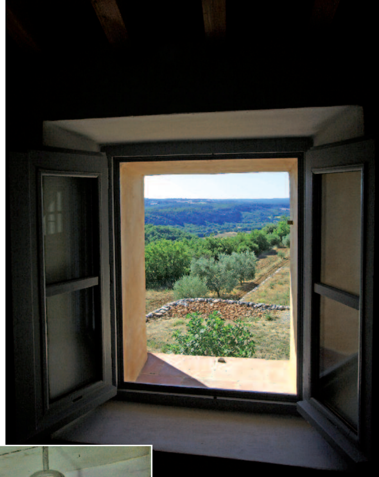
PETITES OUVERTURES POUR PANORAMA GRANDIOSE. Creusées dans l'épaisseur des murs, les fenêtres ont été dimensionnées selon le nombre d'or. Elles gardent la maison au frais durant l'été.
